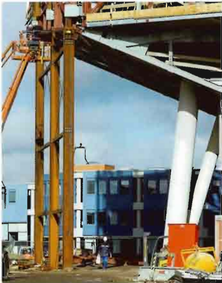
De noordvleugel wordt ondersteund totdat het bruggebouw klaar is en die taak kan overnemen. De foto is genomen vlak voor het vijzelen.
