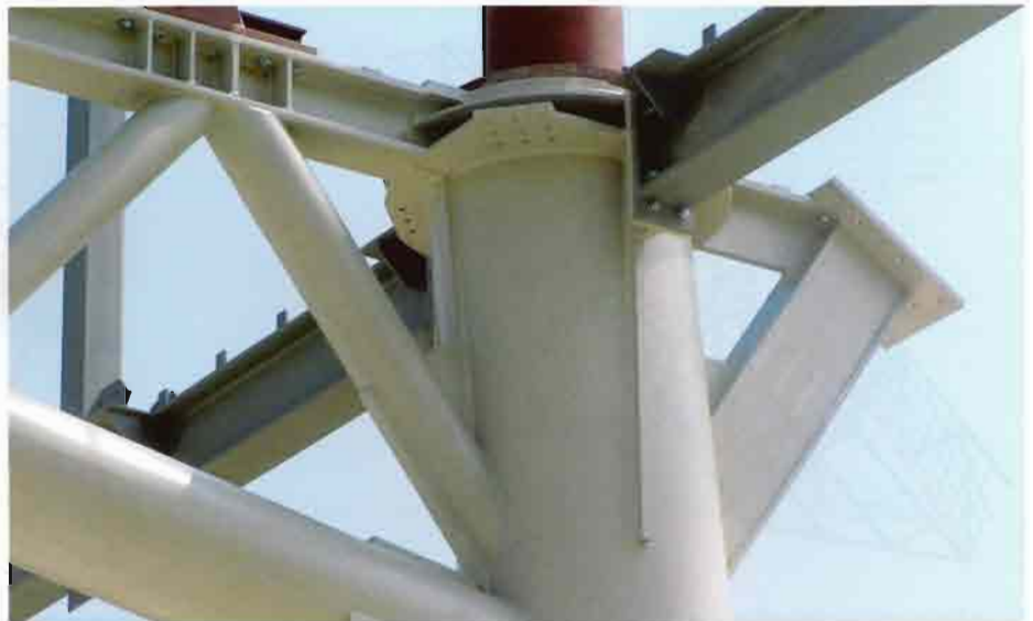
Aansluiting dwarsvakwerk-schuine poot.
